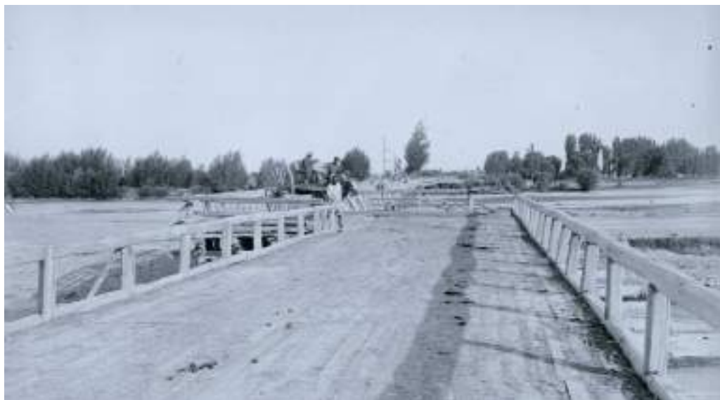
28-29 Два вида на Гульчинский мост, построенный около 1893 г.: мосты строились из арчи – чрезвычайно крепкое и плотное дерево из породы хвойных; очень трудно поддается гниению, даже в воде
